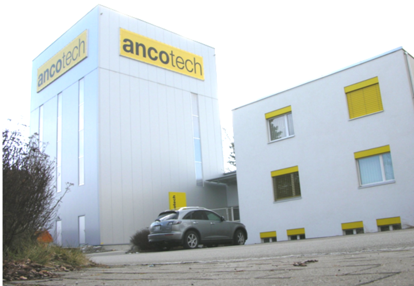
Сградата на АНКОТЕК в Дийлсдорф - Швейцария
